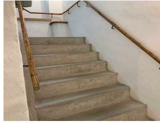
Treppe zwischen EG und UG
