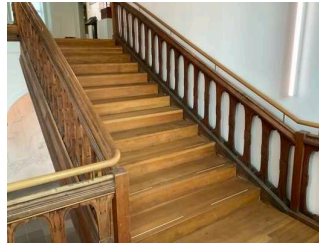
Treppe zwischen EG und 1. OG
