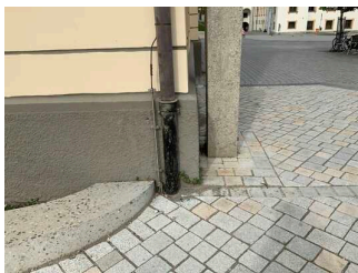
Weg zwischen Parkplatz und Nebeneingang für Rollstuhlfahrer
