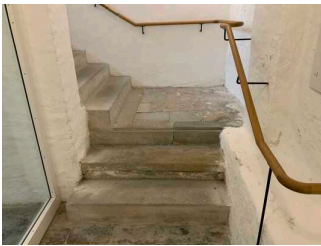
Treppe zwischen EG und UG
