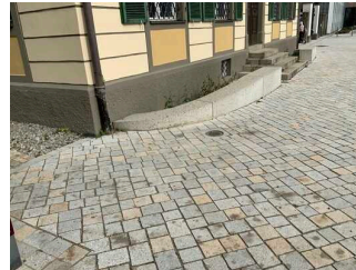
Weg zwischen Parkplatz und Nebeneingang für Rollstuhlfahrer
